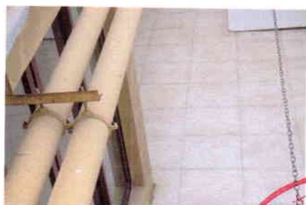
地下室装饰装修
